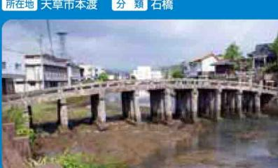
1832年に架けられた石橋で、国指定重要文化財。石造桁橋では日本最大で長さ28.6m、幅3.3m、全國でも珍しい45脚の石柱によって支えられている多脚式です。この石橋は、天草市下浦地域から採掘された砥石層の砂岩を、下浦の石工が加工したもの。
