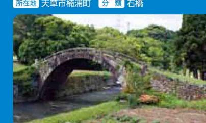
熊本県指定文化財である石橋。1878年に完成したアーチ型の石橋で、長さ26.33m、幅3.05mの優美な姿をしています。この橋には下浦石が用いられ、下浦の石工の手によってつくられています。
