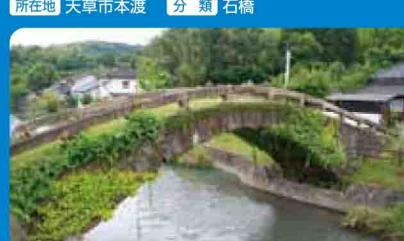
橋の長さは22.73m、幅3.24mの石橋で、壁石が薄い単一アーチの眼鏡橋。1882年に架けられ、熊本県指定文化財もあります。石材には下浦石が利用され、天草で唯一、架橋碑が現存する貴重な石橋です。
