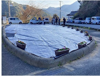
花壇整備・防草シート設置
