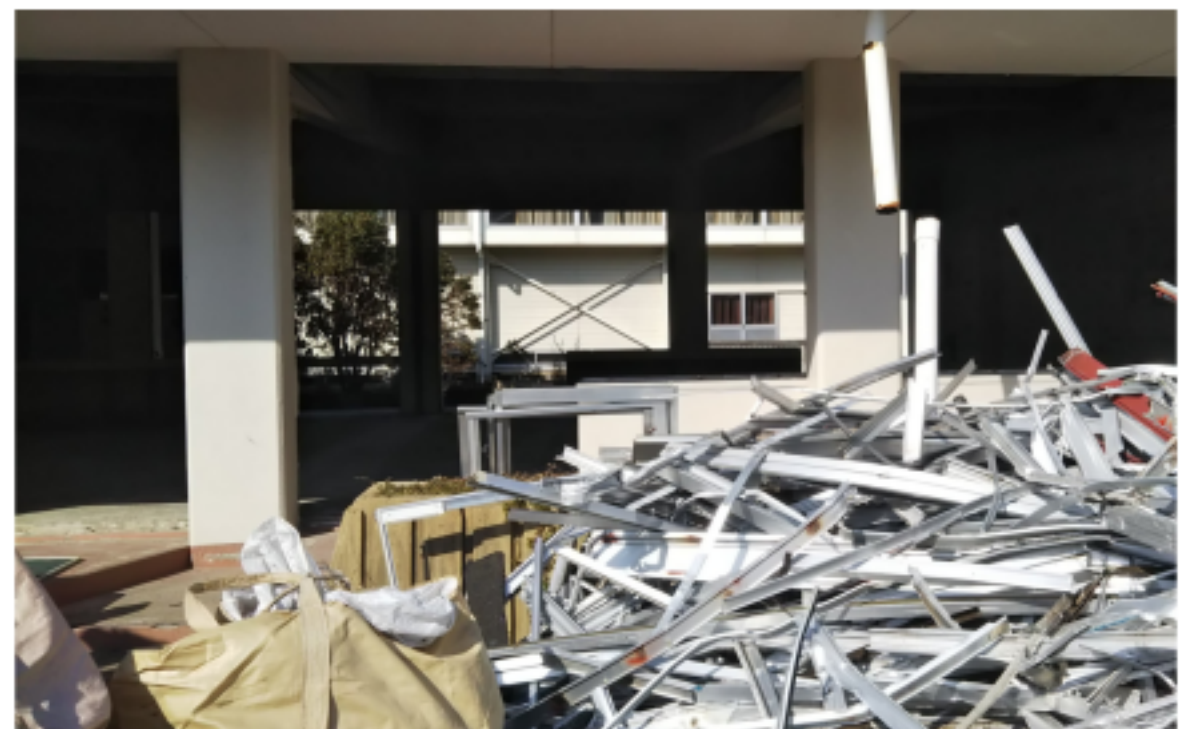
高学年棟 グラウンド側 窓のサッシがすべて撤去されました。
