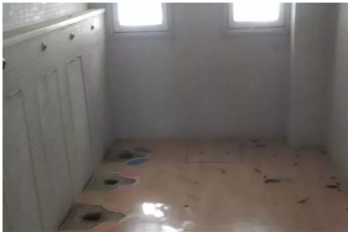
高学年棟 男子トイレ 便器・扉などが撤去
