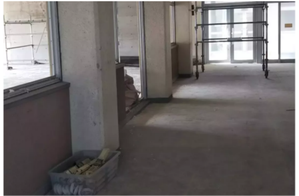
高学年棟 廊下 床材がすべて剥がされました。
