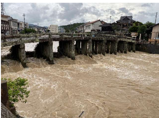
↑ 下流側からみた祇園橋
