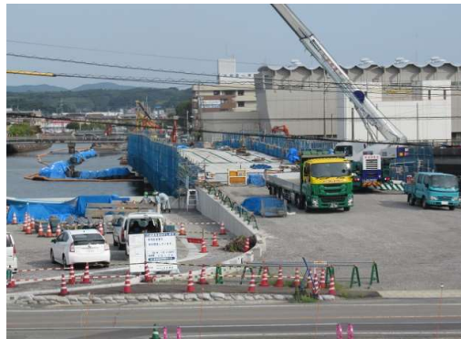
建設中の橋方面から町山、口川に
