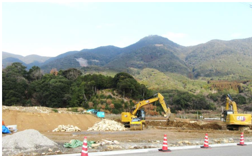
急ピッチで進む造成工事＝(仮)ガイダンス・支所建設予定地
