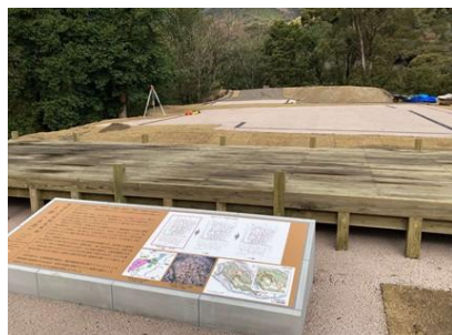
【I 郭の整備工事途中】
