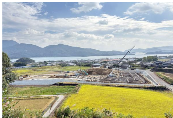
〔10月末時点の戦国ミュージアム工事現場〕
