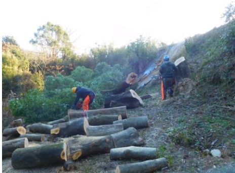
【I郭の側で伐採の様子】
