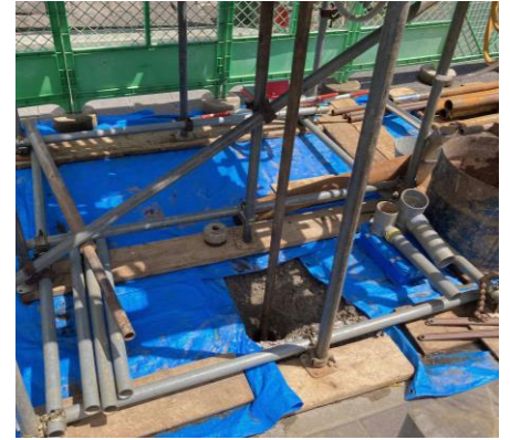
【機械が入るだけの穴を掘り進め、完了後は埋め戻します】
