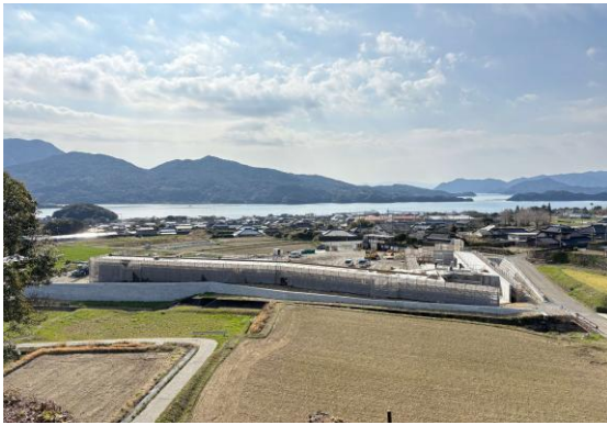
【令和8年3月末の工事の様子】
