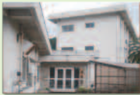
●手前が風呂と食堂棟、奥が寮棟(旧男子寮)
