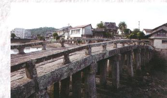
1832(天保3)年に架橋した。天草産石材である下浦石(砂岩)を用いた多脚式アーチ型石橋。橋がある町山口川の周辺は、1637(寛永14)年、島原・天草一揆で激戦地となった場所の一つである。
