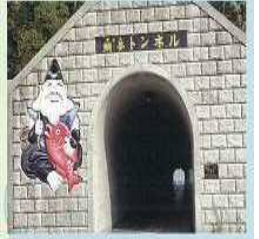
①鯛夢トンネル
