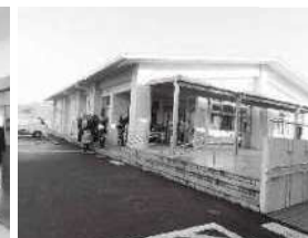
▲久喜宮地域防災拠点施設
